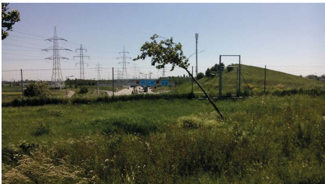
Abbildung 2: Fehlende Sichtschutzpflanzungen auf der Grünbrücke Rothneusiedl an der S 1 Süd (Mai 2017)
