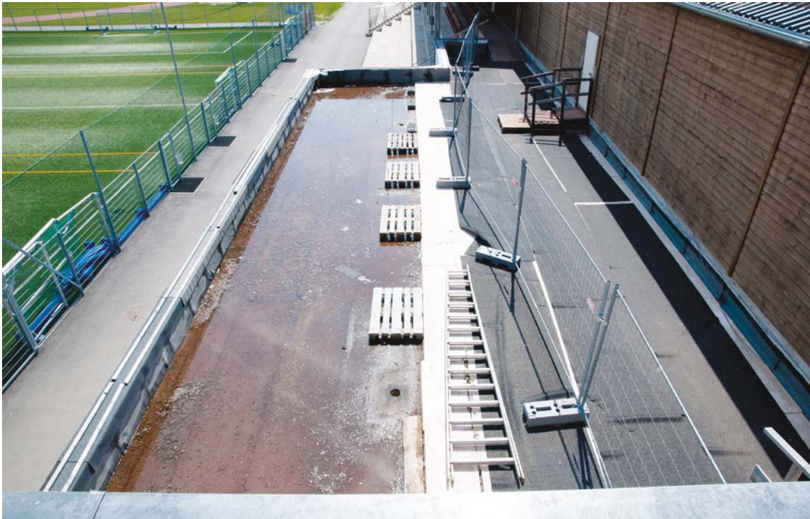
Abbildung 3: Provisorischer Bauabschluss im Bereich Gymnastikraum
