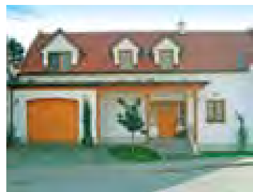
Dem Sektor Sanierung wird im Sinne des Klimaschutzes größte Wichtigkeit zugemessen.
